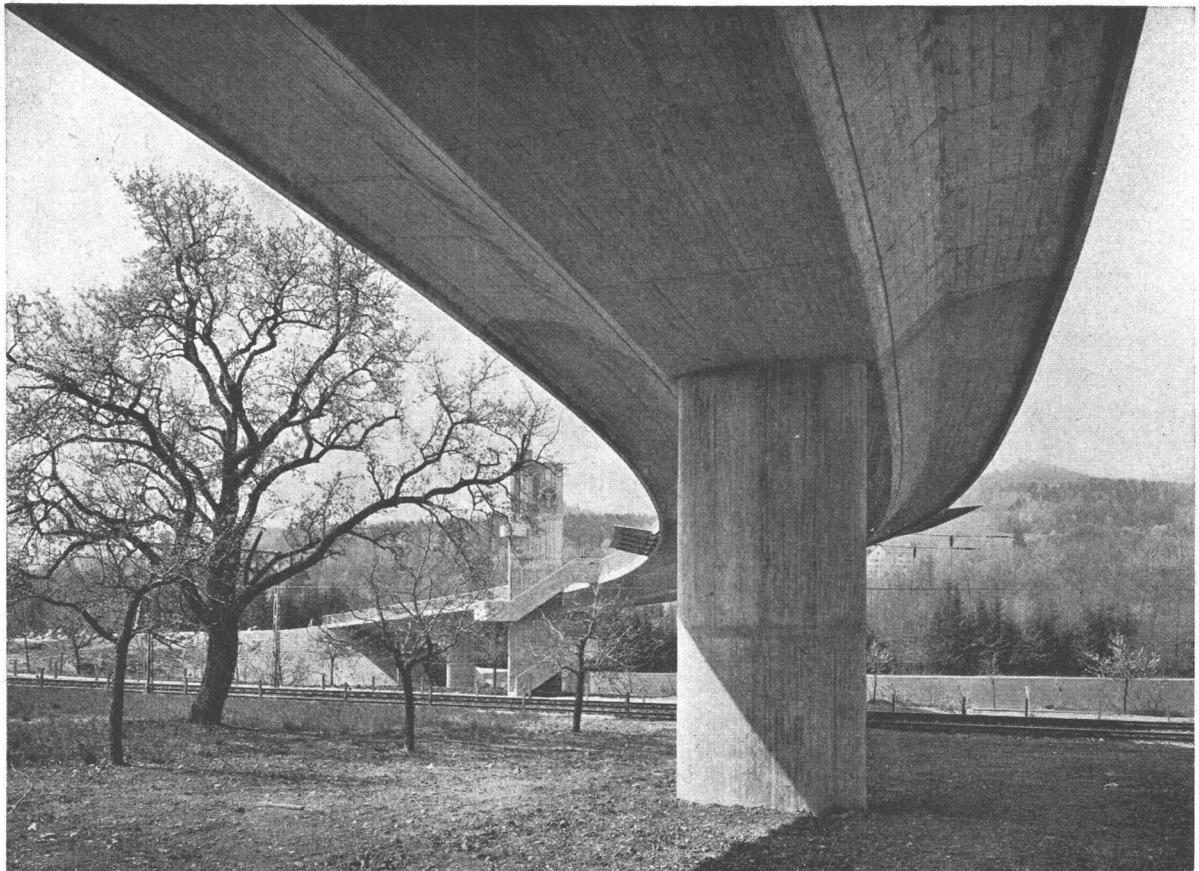
Cementfabrik Holderbank-Willegg AG: Strassenbrücke in Spannbeton
