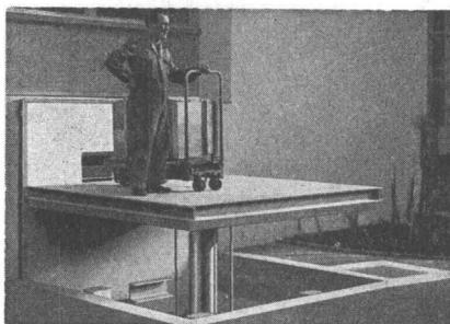
Hydraulische Hebebühne für den Warenumschlag in einem Industriebetrieb. - Hubkraft 3000 kg, Bühnengröße 2,5 X 2,5 m.
