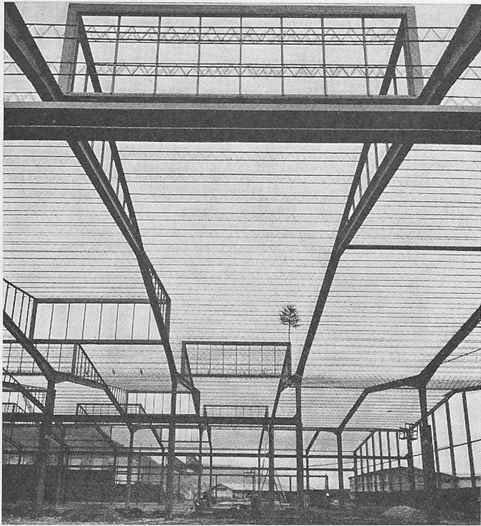
Bild 9. Quer-Durchblick im Montagestadium. Trotz noch fehlender Verspannung sind die nur aus Flacheisen 35 x 10, 40 x 12 und 50 x 12 sowie Rundeisen \phi 10 und 12 mm bestehenden, 9 m weit gespannten Pfetten bereits gut ausgerichtet
