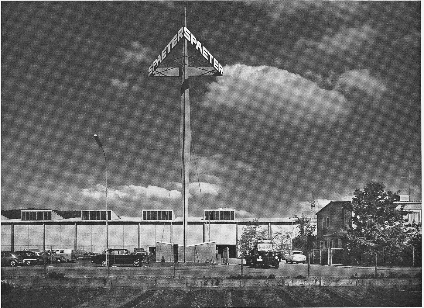
Bild 3. Pylon mit Bürogebäude bei Ein- und Ausfahrt an der Sternfeldstrasse. Im Hintergrund ein Teil der Westfassade der Lagerhalle
