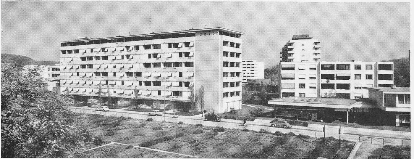
Ansicht der Ueberbauung aus Südwesten, rechts Ladenbauten
