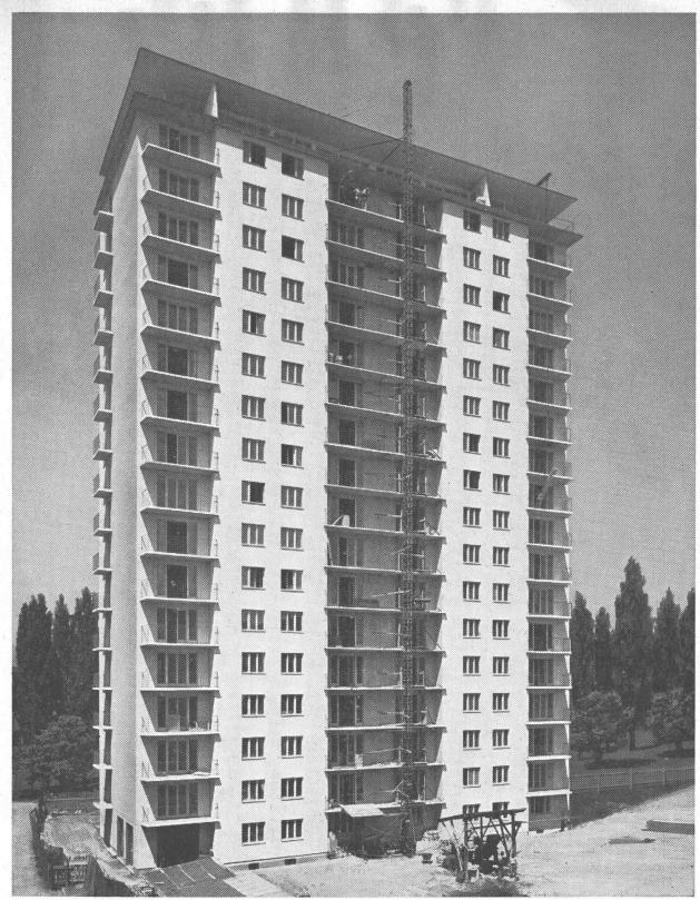
18-geschossiges Hochhaus in Graz, ausgeführt in Durisol-Mauerwerk
