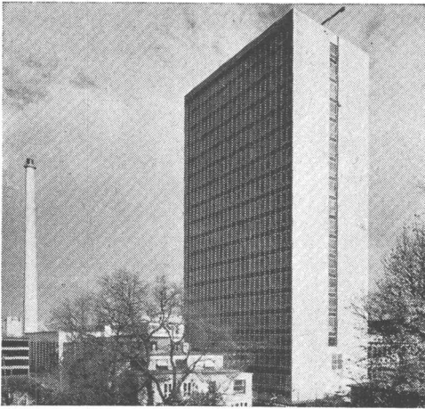
Im Hochbau für hohe Festigkeiten
