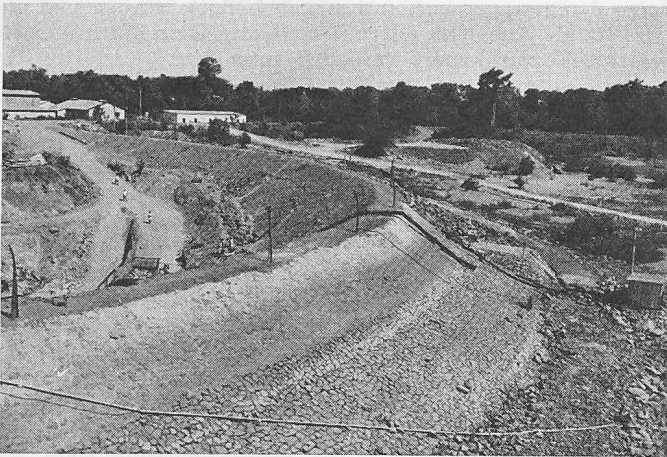
Bild 10. Unterwasserseitiger Fangdamm während der Niederwasserperiode im April 1961
