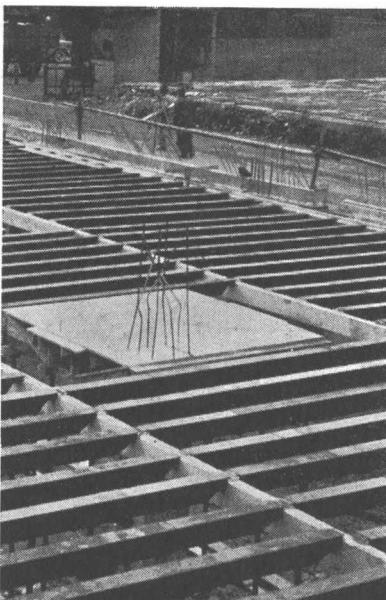
Für vollkommen ebene Decken Rückziehbare Auflagezeugungen Breite Auflagefläche Leicht verstellbar Spart Abstützungen Lange Lebensdauer
