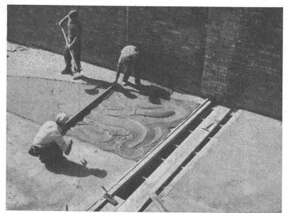
Ausführung in unserem bewährten zweischichtigen PORA-Porenbeton GLEICHZEITIG THERMISCHE ISOLIERUNG UND GEFÄLLSBETON LEICHT, HOCHISOLIEREND ABSOLUT FÄULNISSICHER
