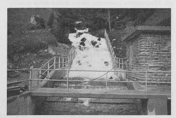
Fig. 30. Prise d'eau du torrent du Moulin
