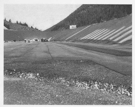
Fig. 23. Bassin de compensation de Motec. Revêtement du bassin, couche filtrante, couche drainante, béton bitumineux
