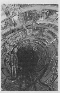
Fig. 27. Galerie de Vissoie, zone en mauvais terrain, grande déformation des cintres métalliques
