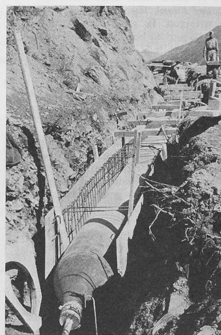
Fig. 12. Conduite à flanc de coteau de Blumatt, coffrage «Ductube»  $\phi$  60 cm
