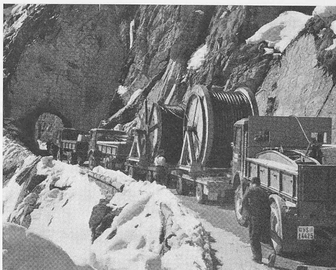
Fig. 3. Transport du câble pour blondins entre Grimentz et Moiry le 5 avril 1956
