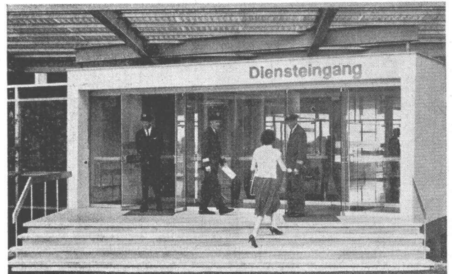
TORMAX im Flughafen Zürich-Kloten: acht Ganzglas-Doppeltüren, angetrieben durch je einen TORMAX-1. Die Steuerung erfolgt durch Kontakt-Teppiche.
