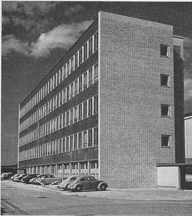
Bild 28. Ansicht des Bürobaues der Giesserei von Südwesten
