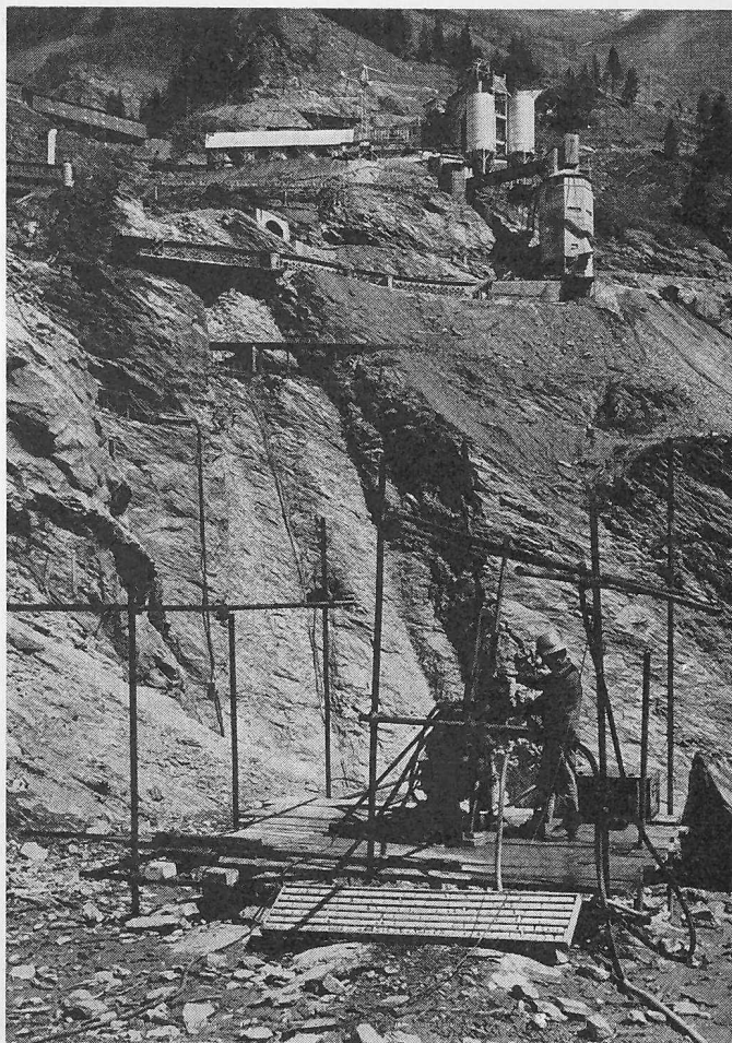
Bild 6. Bohrmaschine im Einsatz an der linken Talflanke der Staumauer Luzzzone
