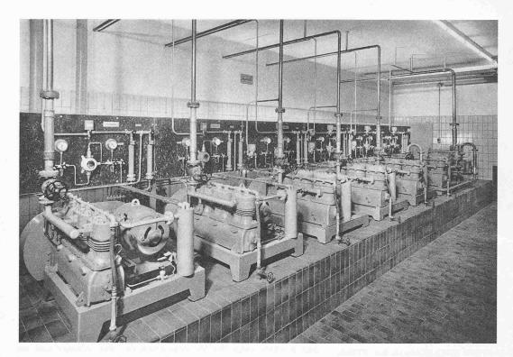
Bild 7 (links). Blick in den Maschinenraum. Vorne links die beiden Einheiten G und F für die Tiefkühlräume I und II, nach rechts anschliessend die drei Gruppen C, D und E für die Räume III, IV und V, ganz links die zwei Maschinen A und B für den Schnellgefriertunnel. Ueber den Maschinensätzen das kältetechnische Tableau
