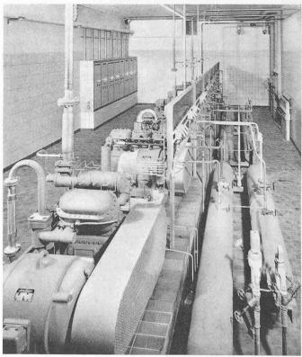
turen (+5°C) ohne Nachregulieren einen sicheren Betrieb gewährleisten. Der abziehende Dampf wird im Wärmeaustauscher so stark überhitzt, dass die Saugleitungen auch ausserhalb der Kühlräume nicht isoliert werden müssen.
