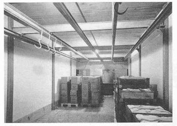
Bild 3. Blick in den Schnellgefriertunnel, hinten der Luftkühler mit geöffneten Leichtmetallklappen
