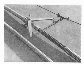
Bild 14. Aufziehen des Hüllrohres über das Drahtbündel
