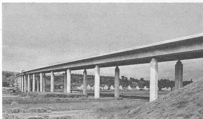
Bild 4. Brücke am Kettiger-Hang bei Weissenthurm/Rhein. Stras- senbrücke über 13 durchlaufende Felder von je 39,20 m Spannweite mit gekuppelten Spanngliedern BBRV (13 Kupplungsstellen); Breite 18,14 m. Brückenaufleger noch unverkleidet. (Foto: Strabag Bau AG, Köln-Deutz)
