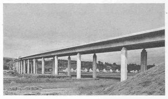
Bild 4. Brücke am Kettiger-Hang bei Weissenthurm/Rhein. Strassenbrücke über 13 durchlaufende Felder von je 39,20 m Spannweite mit gekuppelten Spanngliedern BBRV (13 Kupplungsstellen); Breite 18,14 m. Brückenauflager noch unverkleidet. (Foto: Strabag Bau AG, Köln-Deutz)
