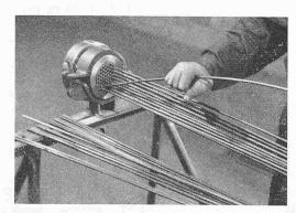
Bild 15. Durchstossen der Drähte durch den Anker-Grundkörper
