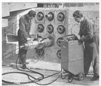
Bild 2. Vorspannende eines Brückenträgers ( $L=2\,\mathrm{x}\,16\,\mathrm{m}$ ) mit 11 Ankern C 170 t. Geräte: Elektrische Vorspanngruppe BBRV für 200 t Maximalkraft.
