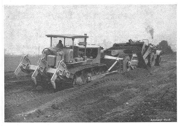
Baustelle Grauholz der künftigen Autobahn: Caterpillar-Traktor Type DW 20 mit Scraper beim Beladen, geschoben durch Caterpillar-Traktor D 9 mit Bulldozer und Aufreisser
