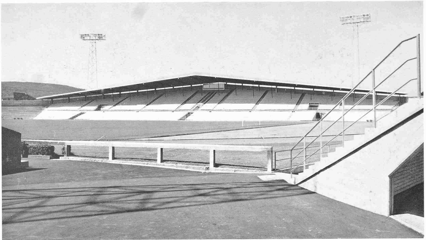
Tribünenbau Herdernstrasse 47. Bauherr: Stadt Zürich. Architekt: Prof. Dr. William Dunkel
