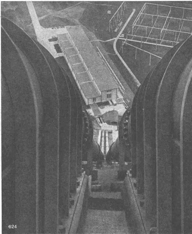
Die Verwendung neuer Stahlqualitäten, die Einführung des automatischen Unterpulverschweissens für Längs- und Rundnähte, handgeschweißte Montage-Verbindungen und die Ultraschallprüfung von Schweißverbindungen nach einer von Gebrüder Sulzer entwickelten Methode, die dem Spezialisten erlaubt, die Prüfung in der Werkstatt oder auf der Montagestelle zuverlässig und rasch durchzuführen, haben den Druckleitungsbau gewaltig gefördert.
