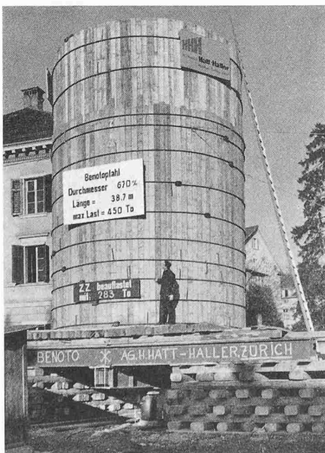
Bild 4. Belastungsprobe bis 450 t auf der Baustelle «Palme» in Zürich
