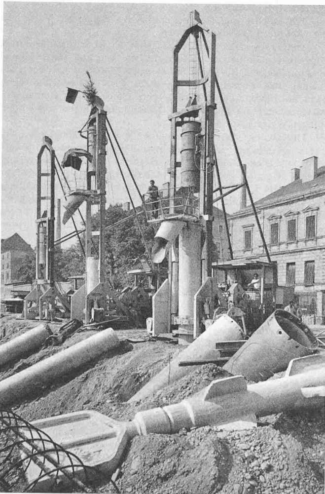
Bild 1. Benoto-Bohrpfahlmaschine EDF 55
