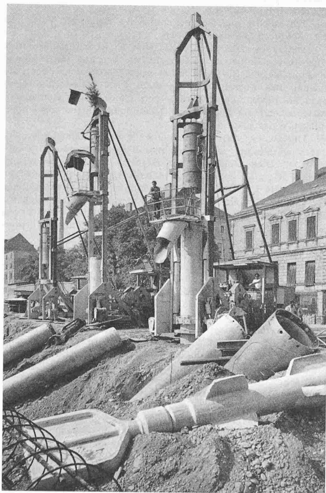
Bild 1. Benoto-Bohrpfahlmaschine EDF 55
