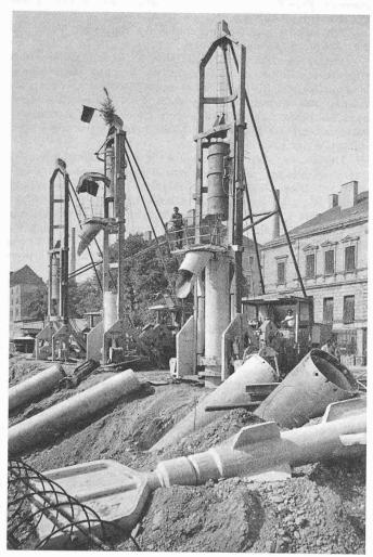
Bild 1. Benoto-Bohrpfahlmaschine EDF 55
