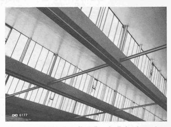
Bild 9. Innenansicht einer Shedhalle mit Fachwerkunterzügen. (Shedhalle für Firma Isofirm AG., Reinach)
