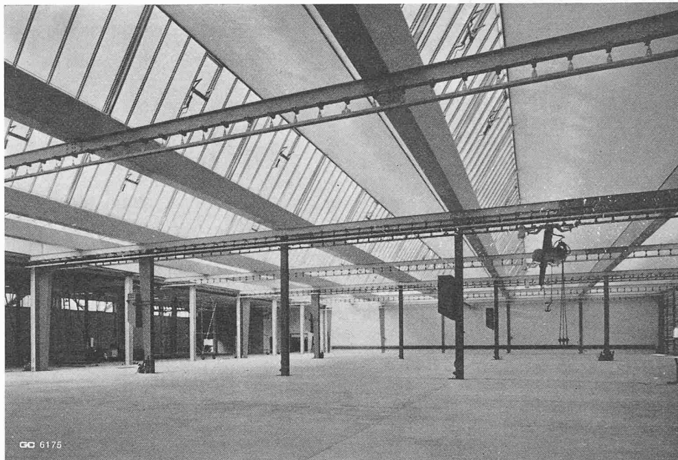
Bild 7. Innenansicht einer mehrschiffigen Halle. Die Zugbänder sind durch Hängekranträger ersetzt. (Shedhalle für Firma Rieter AG., Winterthur)
