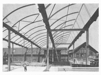
Bild 8. Konstruktion einer mehrschiffigen Halle mit Portalrahmen. (Shedhalle für Firma Georg Fischer AG., Singen)
