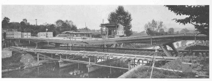
Bild 25. Brücke Opfikon nach Bruchversuch mit zwei Gelenken in der Fahrbahn
