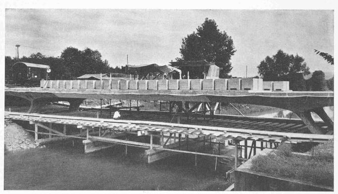
Die Spannbeton-Brücke in Opfikon während der Versuche im Jahre 1960. Gesamtlänge 38,80 m. Weite Mittelfeld 23 m. Gesamtbreite 8,90 m
