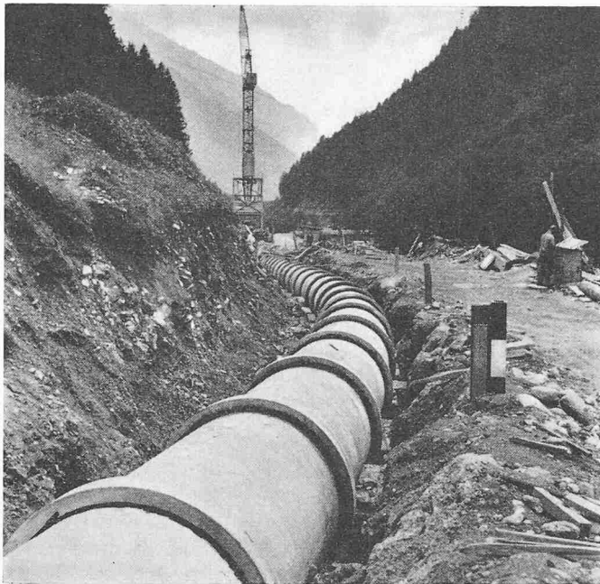
Bild 11. Pumpwasser-Zuleitung zur Zentrale Führen, Bauzustand 17. Aug. 1959
