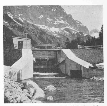
Bild 9. Wehr und Segmentschütze des Ausgleichbeckens Fuhren (Pumpwasserfassung)
