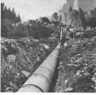
Bild 12. Druckleitung vom Wasserschloss Birchlaui nach der Zentrale Fuhren, Bauzustand 30. Sept. 1959
