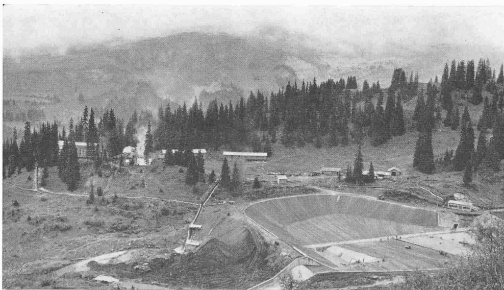
Bild 7. Ausgleichsbecken Teufilai. Rechts Auslauf des Zuleitungsstollens, darüber Schieberhaus und Trafostation. Im Vordergrund Stolleneinlauf und Kronenüberfall. Links, am Fusse des Abschlussdammes, das Schieberhaus für den Grundablass
