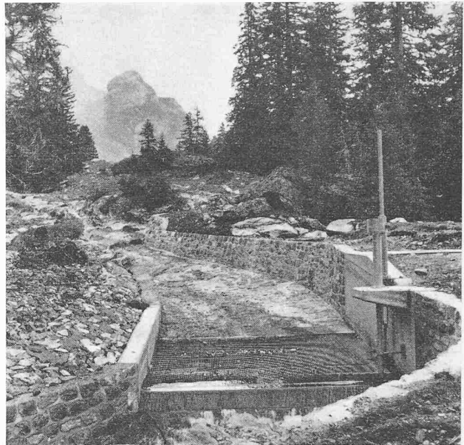
Bild 4. Die Fassung des Henglibaches, horizontaler Einlaufrechen über dem Einfallschacht, rechts Antriebsständer für die Spülschütze
