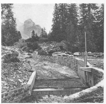
Bild 4. Die Fassung des Henglibaches, horizontaler Einlaufrechen über dem Einfallschacht, rechts Antriebsständer für die Spülschütze
