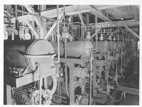
Bild 32. Hydraulische Injektoren mit Antriebsaggregaten und Steuerorganen
