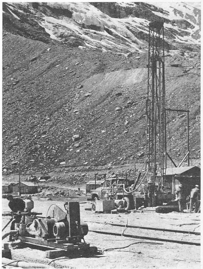
Bild 22. Bohrgerät Rotary Keystone-Frank mit Pumpe
