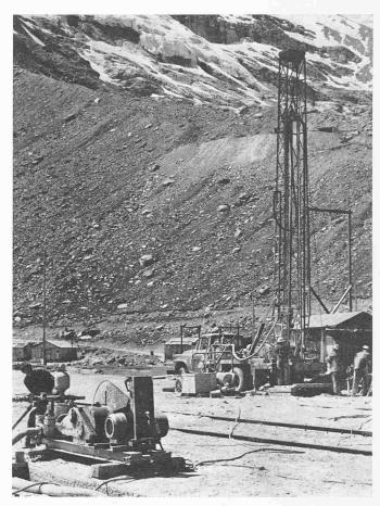
Bild 22. Bohrgerät Rotary Keystone-Frank mit Pumpe
