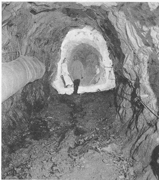
Fig. 6. Galerie de percement du lac d'Issarlès. Rameau incliné de percement avant sautage (distance du lac 2,5 à 3,8 m). Photo H. Baranger
