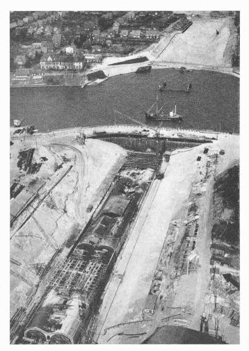
Bild 4. Baugrube Süd, Fangdamm, Kanal und Baugrube Nord
