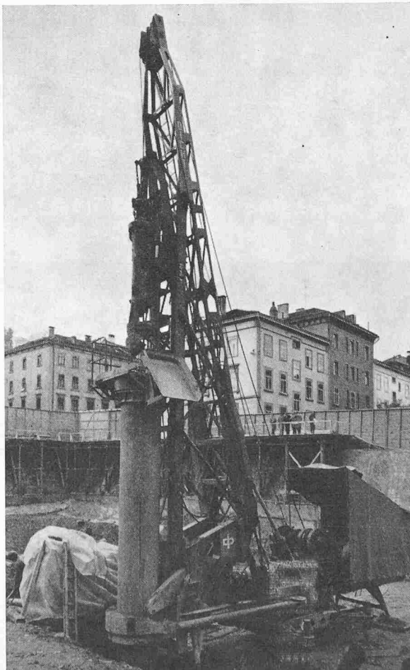
Bild 2. «Sigma»-Pfahlbohranlage
