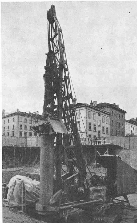
Bild 2. «Sigma»-Pfahlbohranlage
