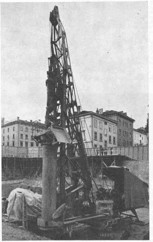
Bild 2. «Sigma»-Pfahlbohranlage
