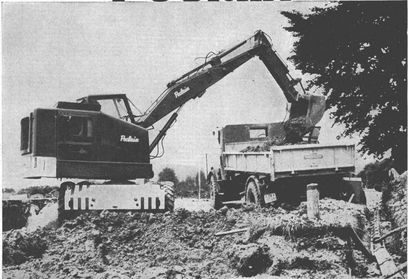
Unser Bild: Verladearbeiten im Strassenkoffer
