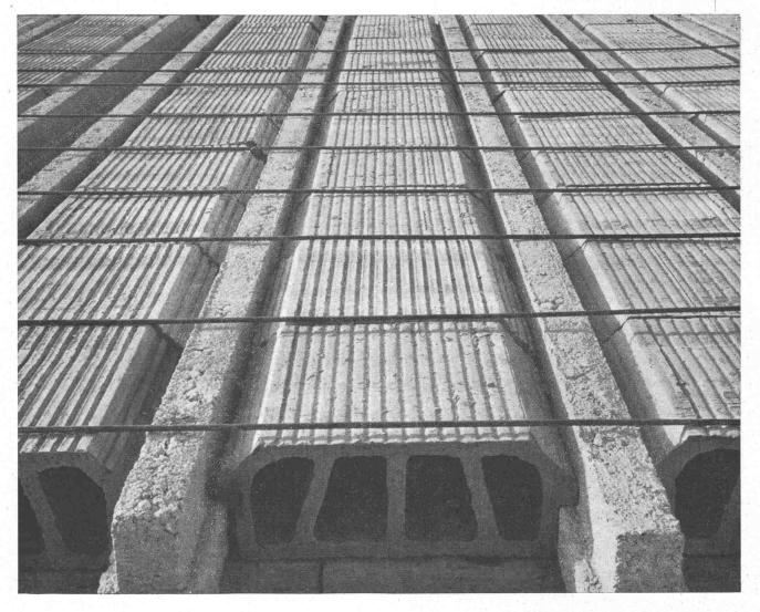
Norma- und Ottiker-Betonbalkendecken verkürzen die Bauzeit und helfen qualifizierte Arbeitskräfte sparen.
