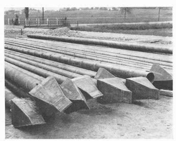
Bild 1. Stapel zur Rammung bereitliegender MV-Pfähle
