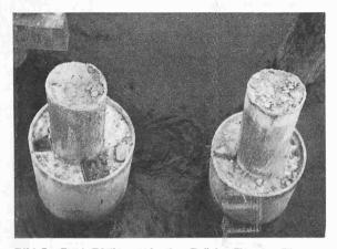
Bild 7. Zwei Pfeilerpiahle der Brücke Beznau. Man erkennt die Ummantelung des eigentlichen MV-Pfahles im Bereiche des freien Wassers (rd. 7 m) mit armiertem Beton, unter Verwendung einer verlorenen Eternit-Schalung
