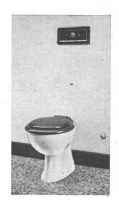
Klosettanlage mit unsichtbarem Spülkasten
