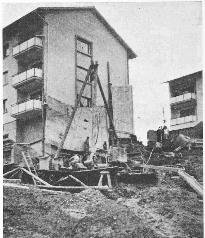
Bild 7. Gebäudeunterfangung an einem Steilhang
