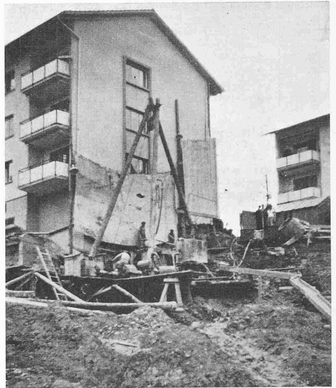
Bild 7. Gebäudeunterfangung an einem Steilhang
