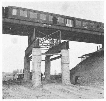
Bild 5. Teilweise ausgegrabene Icos-Veder-Pfähle bei der Belastungsprobe
