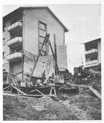
Bild 7. Gebäudeunterfangung an einem Steilhang
