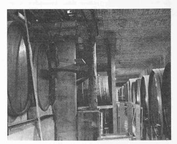
Bild 6. Pfählung in einem Weinkeller, Kellereibetrieb während der Arbeiten voll aufrecht erhalten, keine Erschütterung des Lagergutes
