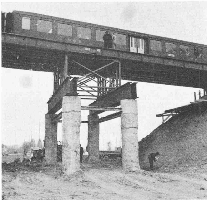
Bild 5. Teilweise ausgegrabene Icos-Veder-Pfähle bei der Belastungsprobe
