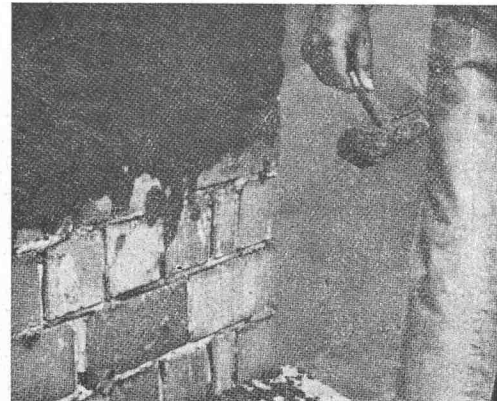
Mörtel mit TRICOSAL-WA fällt beim Verar- beiten weniger ab. Materialverlust ist gering.
