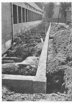
Fig. 4. Déformations horizontales d'une poutre. Puits de reconnaissance
