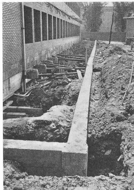
Fig. 4. Déformations horizontales d'une poutre. Puits de reconnaissance
