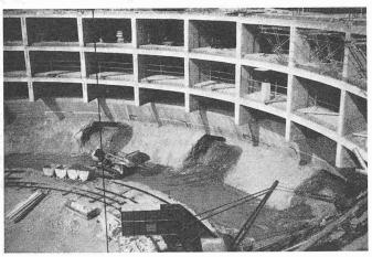
Bild 12. Beginn des Aushubes unter der Schneidenschulter
