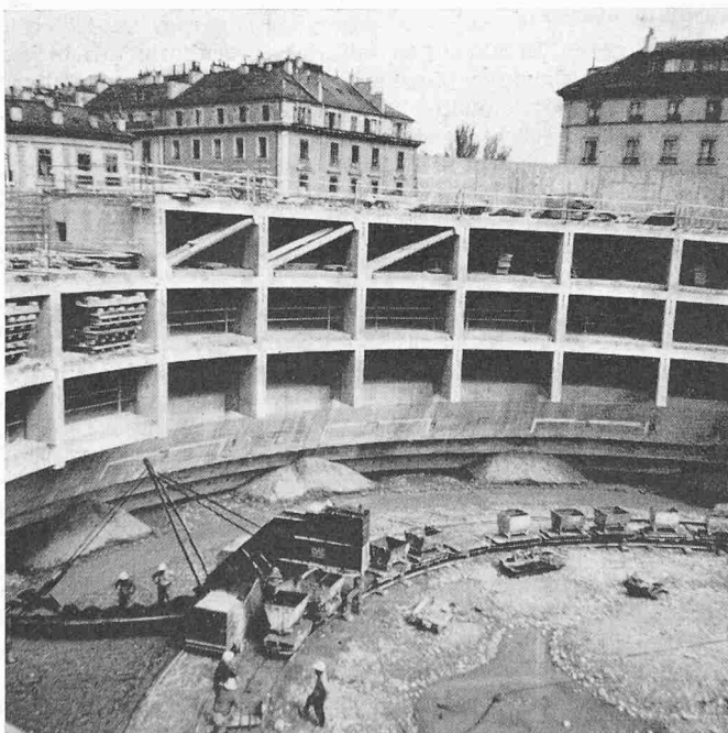
Bild 13. Aushub mit Eimerkettenbagger
