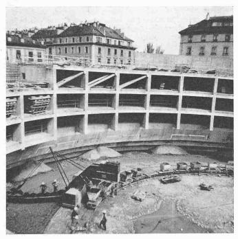
Bild 13. Aushub mit Eimerkettenbagger
