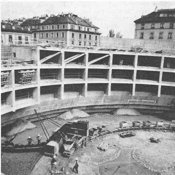
Bild 13. Aushub mit Eimerkettenbagger
