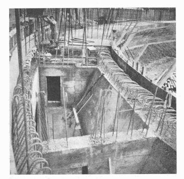
Bild 11. Blick in die Schneide mit Hohlkammern, 5. 2. 60
