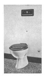
Klosettanlage mit unsichtbarem Spülkasten
