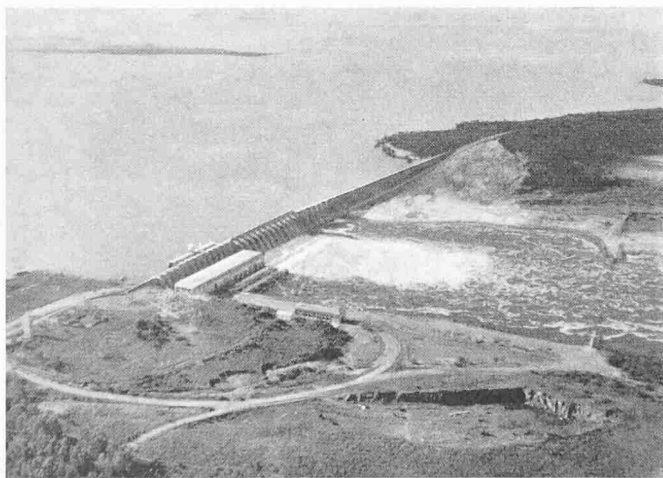
Bild 4. Kraftwerk Rincon del Bonete. Am rechtsufrigen Fuss der Sperre die Zentrale, daran anschliessend das Ueberfallwehr. Das Bild wurde nach der Dammüberflutung aufgenommen. Phot. A. Sonderegger
