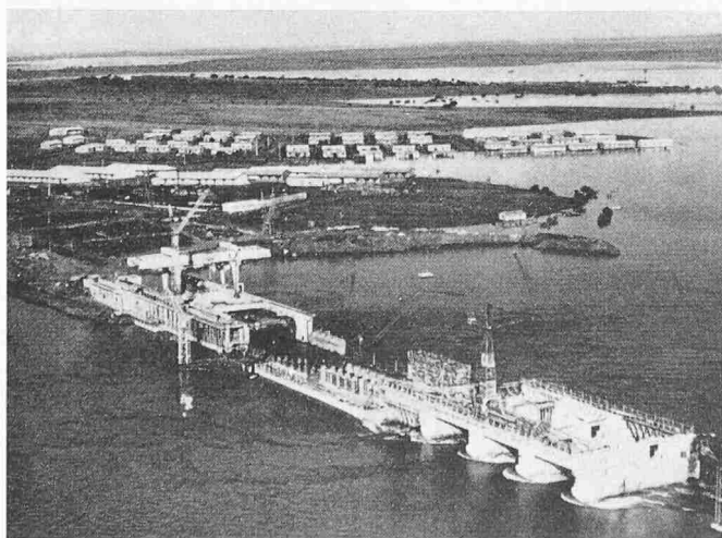
Bild 15. Die überflutete Baustelle des Kraftwerkes Rincon de Baygorria am 25. April 1959. Der Rio Negro führt ungefähr 11 500 m 3 /s. Der Wasserspiegel steht 28 m über dem Normalstand
