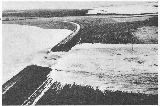
Bild 11. Rincon del Bonete. Gesprengte Bresche im seitlichen Erdamm unter der Zufahrtsstrasse zum Kraftwerk. Dadurch wurde für den See eine geringe zusätzliche Entlastung von rd. 1500 m³/s geschaffen, die jedoch keinen wesentlichen Einfluss hatte (Foto Accion, Montevideo)
