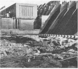
Bild 14. Kraftwerk Rincon del Bonete, Tosbecken des Wehres nach Durchgang des Hochwassers. Im anstehenden Fels sind Auskolkungen von bis 6 m Tiefe aufgetreten
