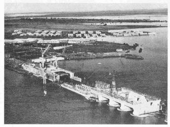
Die überflutete Baustelle des Kraftwerkes Rincon de Baygorria am 25. April 1959. Der Rio Negro führt ungefähr 11 500 m<sup>3</sup>/s. Der Wasserspiegel steht 28 m über dem Normalstand
