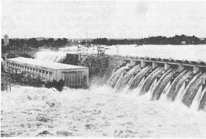
Bild 12 b. Kraftwerk Rincon del Bonete, Ansicht von Wehr und Zentrale am 23. April 1959 mittags 12.00 h. Am rechtsufrigen Dammende sieht man den überfluteten niedrigen Dammteil vor der Zentrale. Das Wehr entlastet rd. 7400 m 3 /s (Foto L. Plata, Montevideo)
