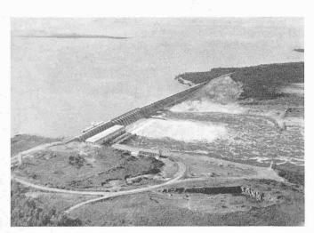
Bild 4. Kraftwerk Rincon del Bonete. Am rechtsufrigen Fuss der Sperre die Zentrale, daran anschliessend das Ueberfallwehr. Das Bild wurde nach der Dammüberflutung aufgenommen. Phot. A. Sonderegger
