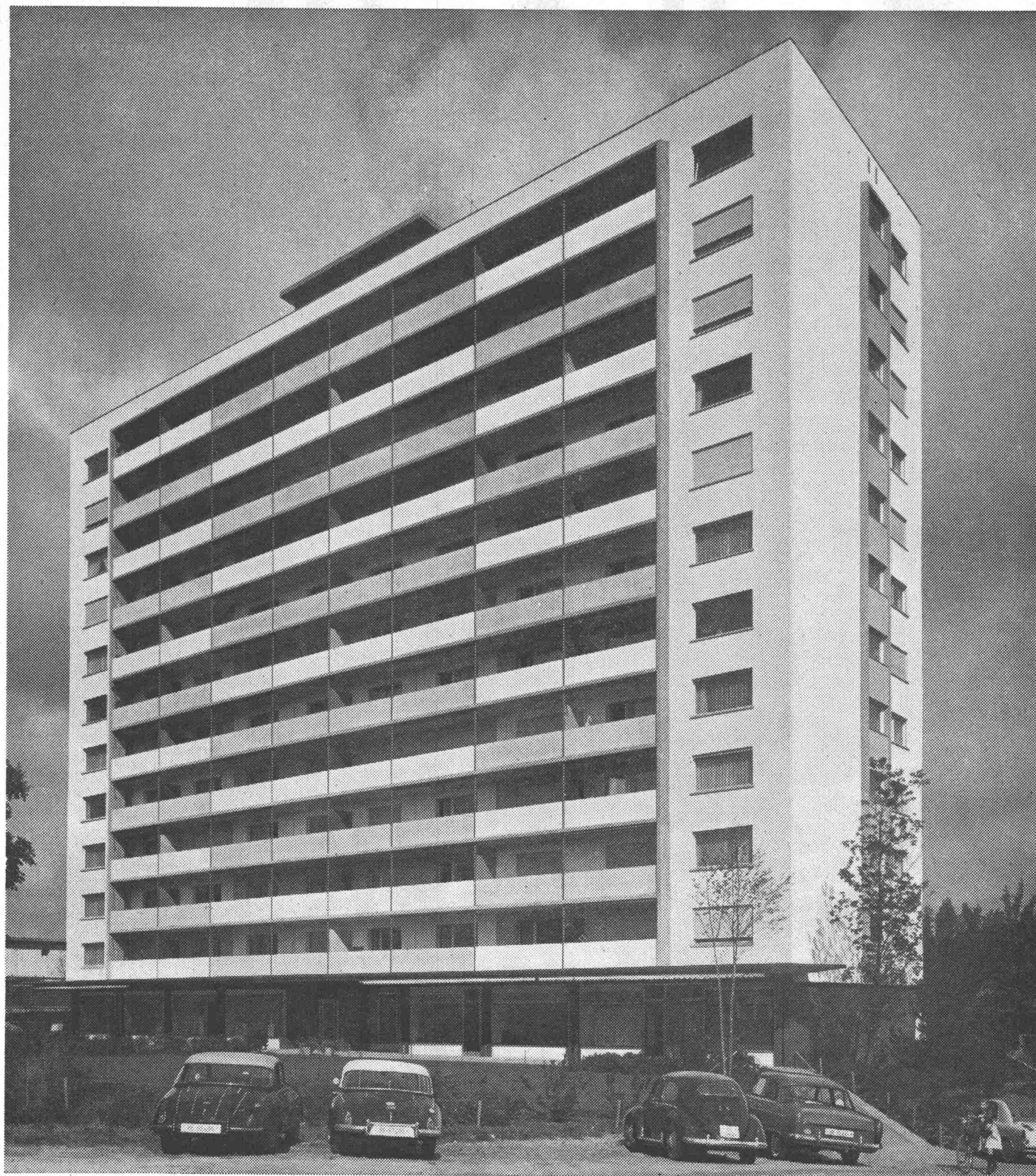
Hochhaus «Kreuzmatten» in Zollikofen bei Bern, ausgeführt in Durisol-Mauerwerk Architekturbüro Max Klein, Bern. Ingenieurbüro Hartenbach & Wenger, Bern
