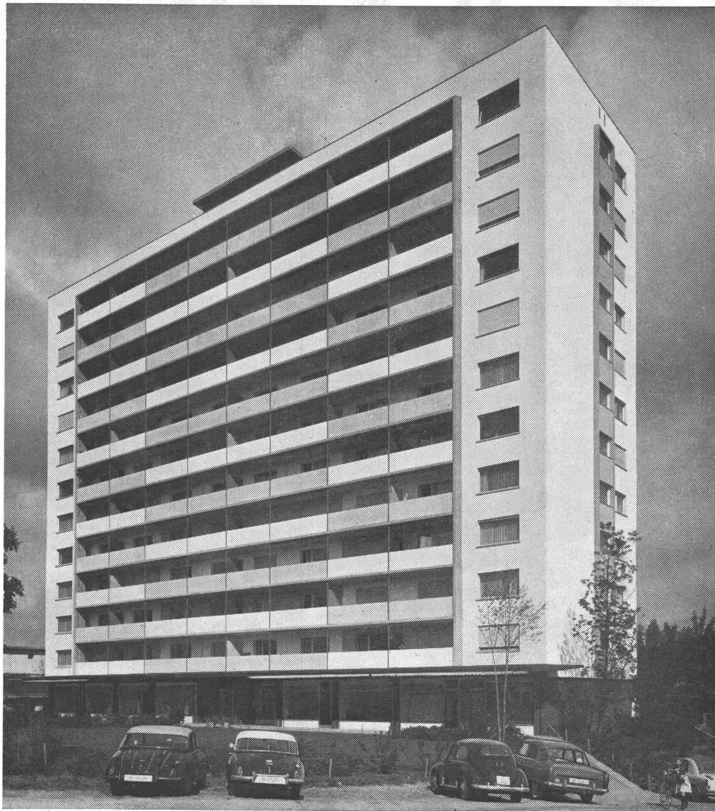
Hochhaus «Kreuzmaffe» in Zollikofen bei Bern, ausgeführt in Durisol-Mauerwerk Architekturbüro Max Klein, Bern. Ingenieurbüro Hartenbach & Wenger, Bern
