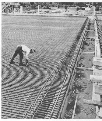
Bild 15. Kunsteisbahn Genf. Links Piste mit Kühlröhren auf Betonklötzen und Querarmierung, rechts Leitungskanal
