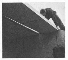
Erfordernisse jeder einzelnen Bauaufgabe. Ein rationeller Produktionsbetrieb ist nicht auf eine Fixierung der Plattenabmessungen oder der Armierung angewiesen. Für den Einbau von Aufhängevorrichtungen, Leitungen, Nuten, Ausspaungen, usw., eignen sich die nachträglich betonierten Fugen, und eine Störung des Herstellungs- und Montagevorganges durch diese Einzelheiten wird vermieden.
