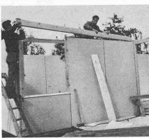
Ein Dachelement, ein Kastenträger auf der Unterseite mit Homogenplatten verschalt, wird aufgesetzt
