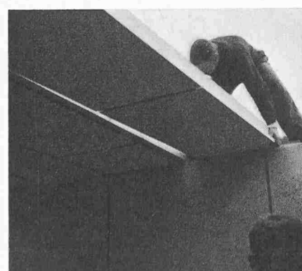
Ein Dachelement, ein Kastenträger auf der Unterseite mit Homogenplatten verschalt, wird aufgesetzt
