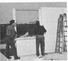
wird auf die bereits aufgestellte Brüstung aufgesetzt
