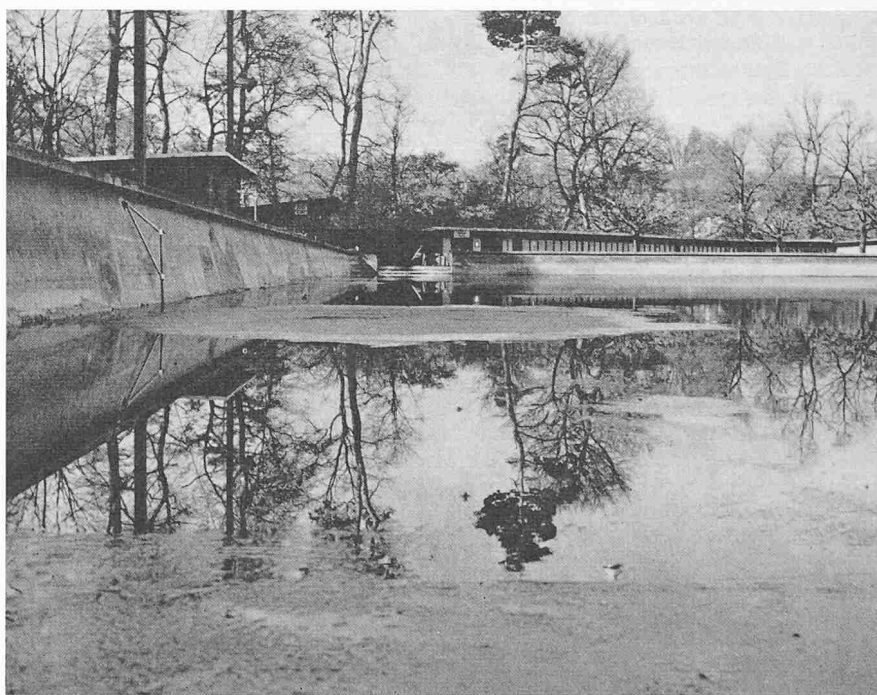
Bild 1c. Frosthebungen der Betonplatte einer Kunsteisbahn. Die Zerstörungerscheinungen am Beton sind deutlich sichtbar
