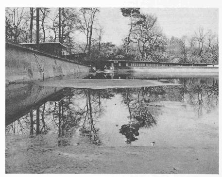
Bild 1c. Frosthebungen der Betonplatte einer Kunsteisbahn. Die Zerstörungserscheinungen am Beton sind deutlich sichtbar
