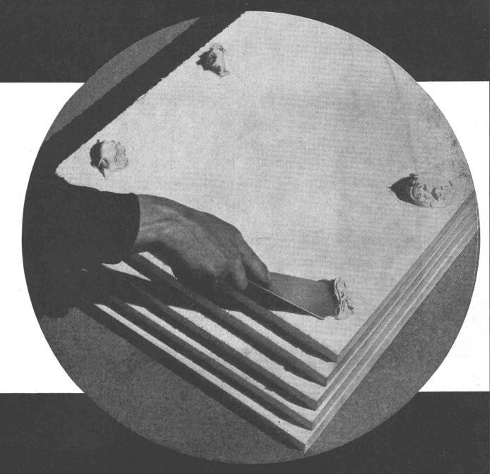
ein sofort haftender Kitt zum Verlegen von Sagex, Wannerit, Syntopor, Alporit auf Beton, Mauerwerk, Holz usw. Hohe Anfangsfestigkeit
