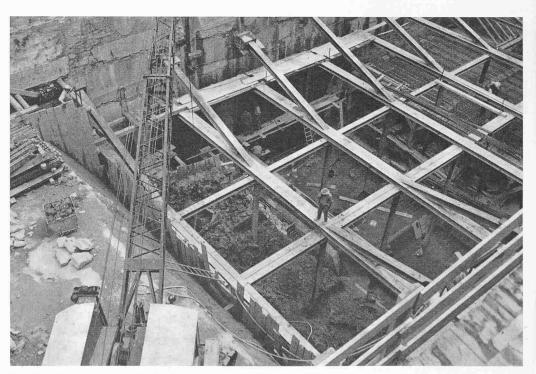
Fig. 15. Terrassement de la fouille par tranches d'environ 4,20 m de longueur. Etayage métallique de la fouille. Travaux de bétonnage des radiers des parois et des murs
