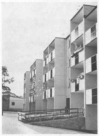
Bild 13. Gutes Beispiel für Elementbauweise: Betonelemente im Mehrfamilienhaus
