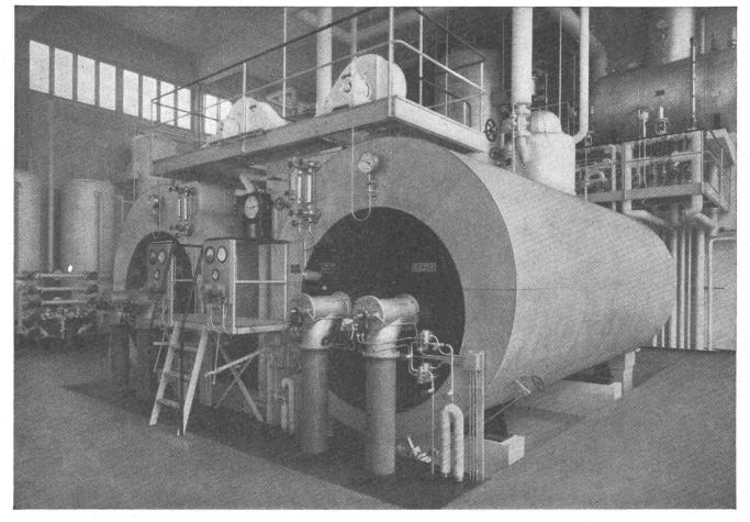
Dreizug-Retourröhrenkesselanlage in einem chemischen Werk, ausgerüstet mit 2 ölgefeuerten Kesseleinheiten für je 3 Mio kcal/h Wärmeleistung, 8 atü Betriebsdruck.
