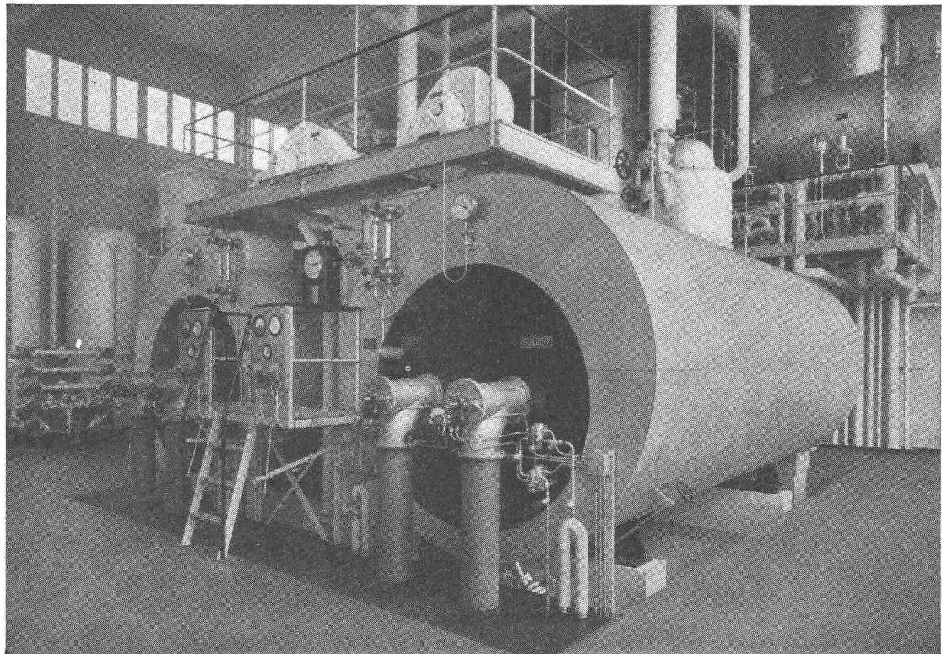
Dreizug-Retourröhrenkesselanlage in einem chemischen Werk, ausgerüstet mit 2 ölfgefeuerten Kesseleinheiten für je 3 Mio kcal/h Wärmeleistung, 8 atü Betriebsdruck.
