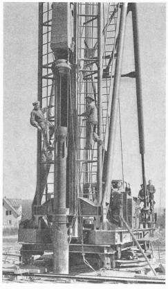
Bild 10. Freifallhammer, Schlaghaube, Mantelrohr- und Stössel-Aufhängung
