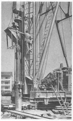
Bild 11. Betonkübel in Einfüllstellung
