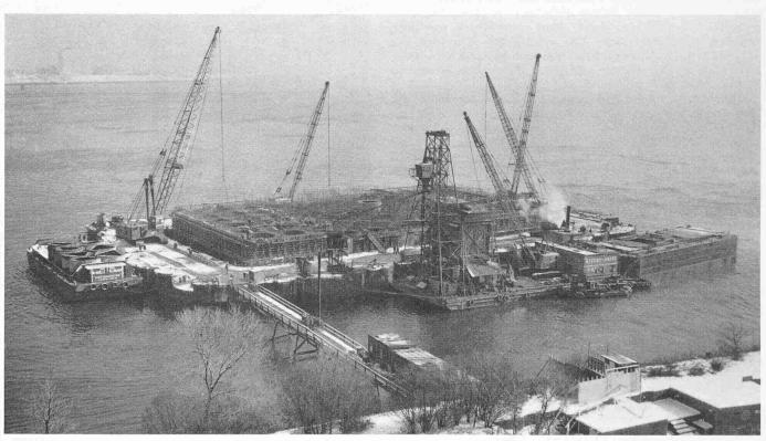
Bild 6. Fundament des Pylons Seite Staten Island, Blick gegen Südosten am 30. Dez. 1960. Plazieren der Schalungen für die elfte Betonieretappe
