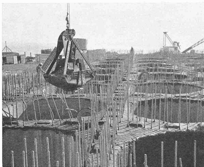
Bild 7. Fundament des Pylons Seite Brooklyn, Aushub während der zweiten Absenketappe (22. Dez. 1960)
